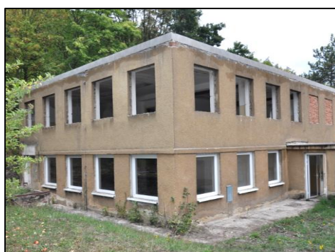
Rekonstrukce pavilonu dílen
